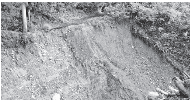
古野蓬線、土砂崩れ現場
