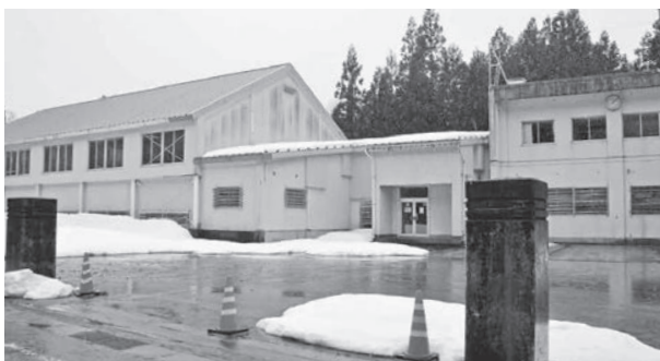
避難所（旧三俣小学校）
