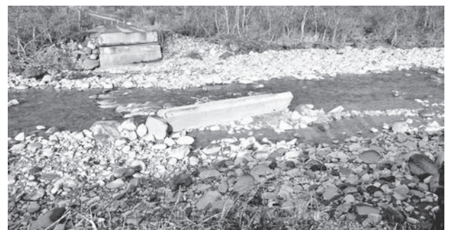
三俣地区の仮橋
