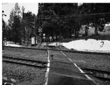
土樽松川浄化センターから続く鉄道横断部分
