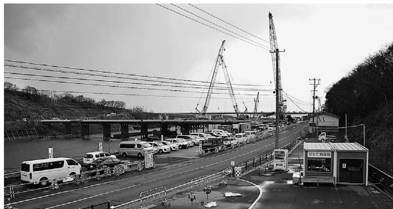
信濃川大河津分水路 令和の大改修現場
